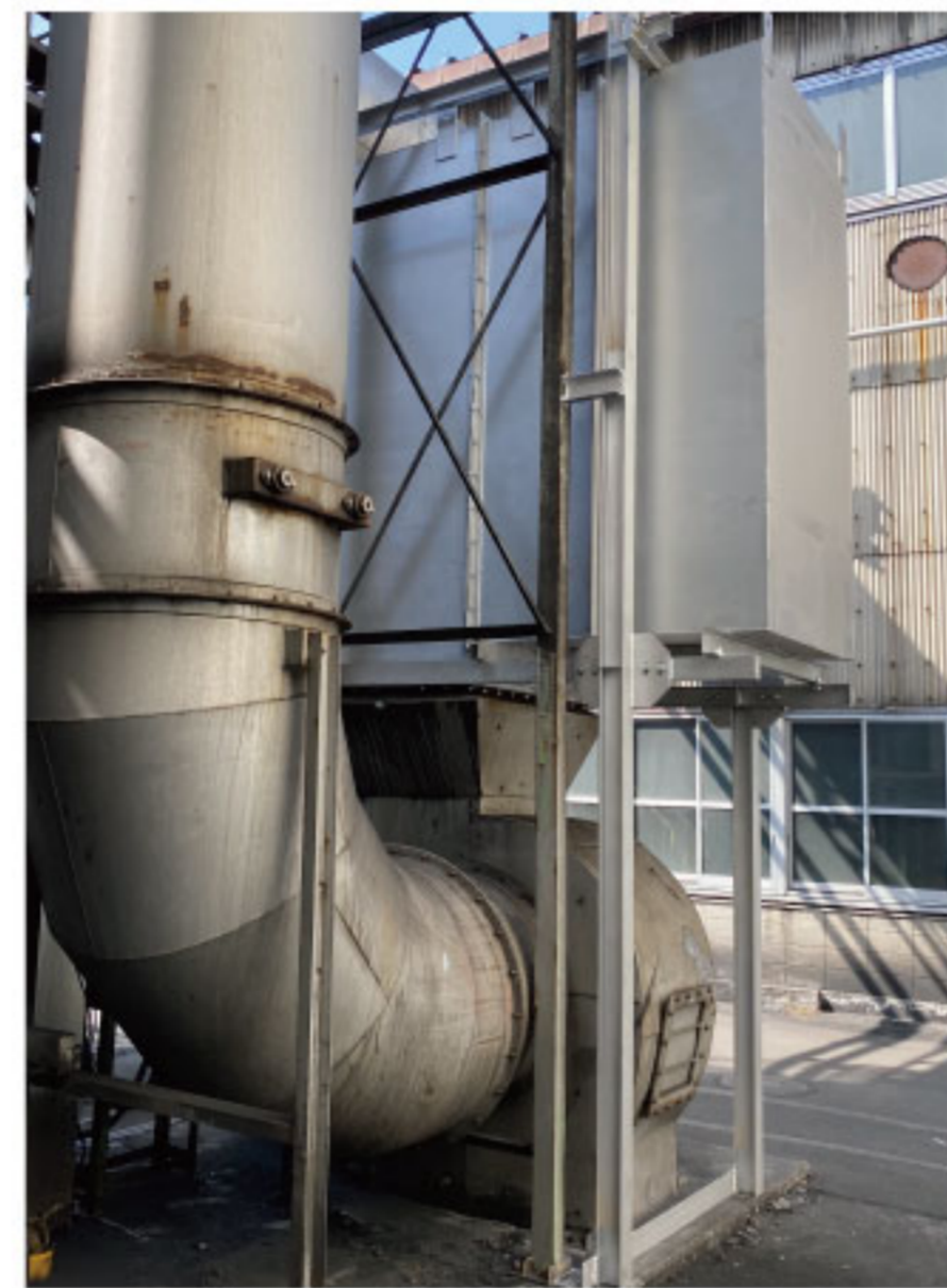
設置後:RASK排気口サイレンサー (内部:鑄鉄ラスク・アルミラスク)
