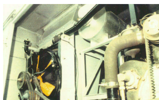
鋼板内側にラスクを貼り付ける 機器設置後のブローアーク内部
