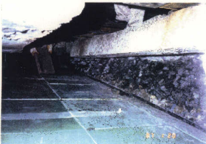
高架スラブの上に敷き詰められたレジんラスク
