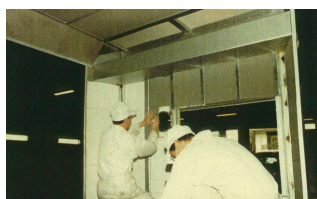
鋼板内側にラスクを貼り付ける 機器設置後のブローアーク内部
