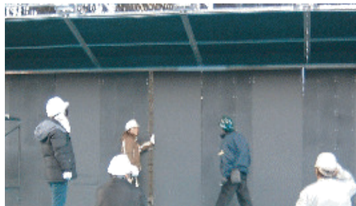
遮音壁の施工
