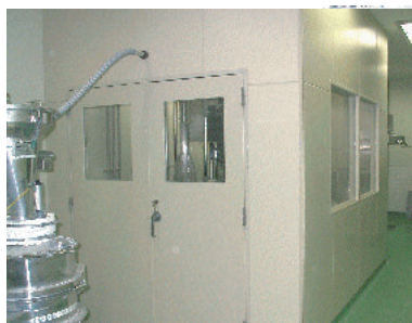
工場内防音室
